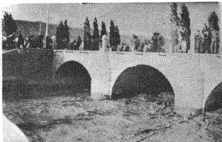
پل منصوروسیل ۲/ مرداد / ۱۳۱۳ در تبریز
