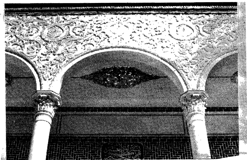
گوشه‌ای از ساختمان دانشکده
