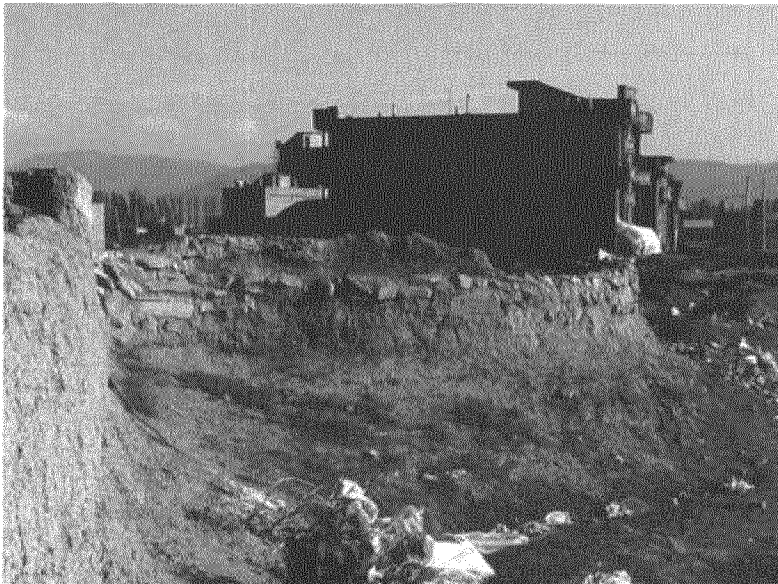
نمایی از بقایای تنها برج نگهداری دیوار محافظ شهر دیلمان
